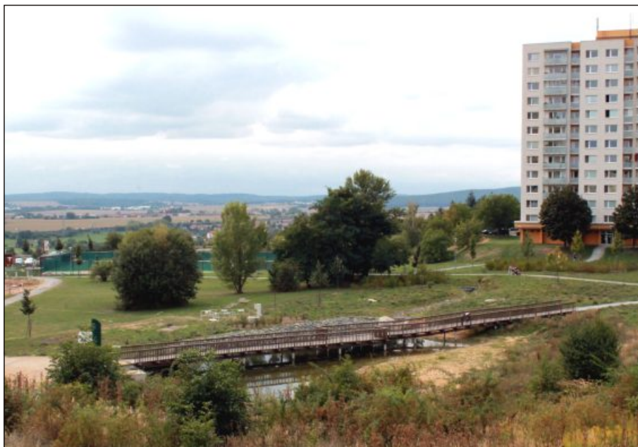
Celkový pohled na vodní plochu, která slouží jako retenční nádrž s dešťovou vodou.
