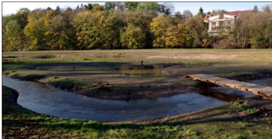
Nové revitalizační koryto Rokytky – lávka.
