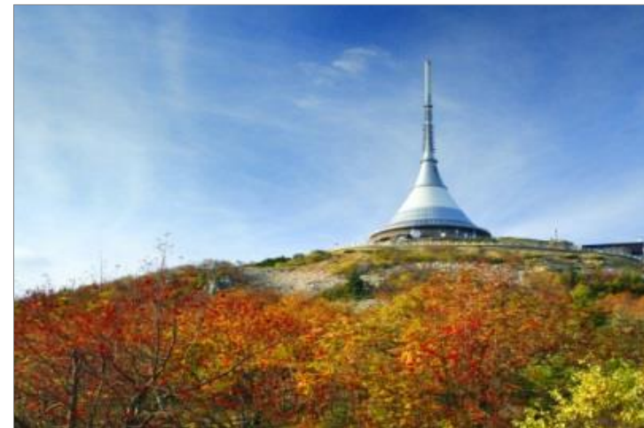
Obr. 21: Vysílač Ještěd – zastavěná přírodní dominanta, významná stavební dominanta
