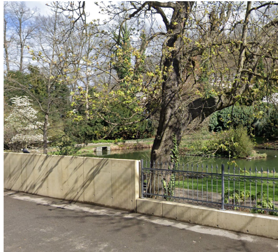
Betonová zeď okolo areálu Botanické zahrady Jarov - ulice Pod Táborem
