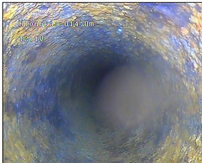
16,4 m (od O.B.) obnažená Fe výstroj, minerální nárůsty Fe 2 O 3 (PŘED) 16,8 m (od O.B.) otevřená perforace (PO)
