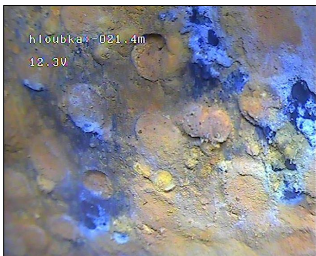
23,1 m (od O.B.) uzavřená perforace minerálními nárůsty (PŘED) 22,9 m (od O.B.) otevřená perforace (PO)
