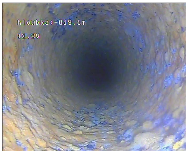
21,4 m (od O.B.) zcela uzavřená perforace minerálními nárůsty (PŘED)
