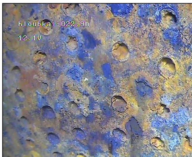
23,1 m (od O.B.) uzavřená perforace minerálními nárůsty (PŘED) 22,9 m (od O.B.) otevřená perforace (PO)
