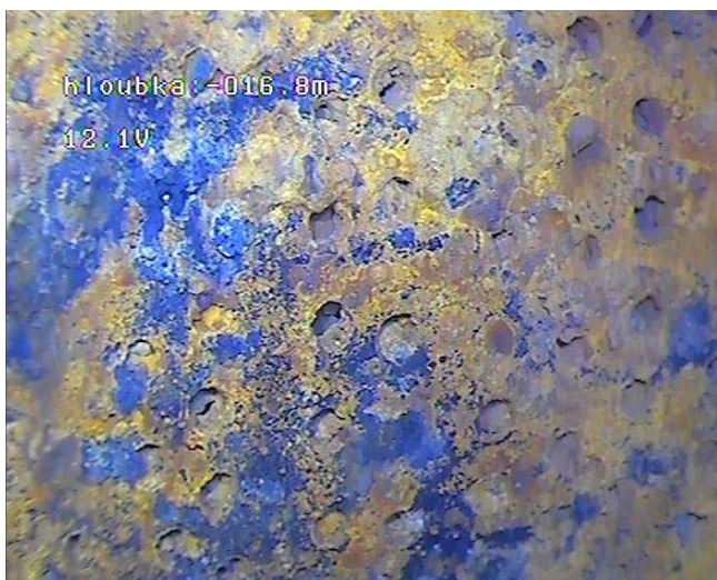
17,4 m (od O.B.) zcela uzavřená perforace minerálními nárůsty (PŘED) 17,8 m (od O.B.) otevřená perforace (PO)
