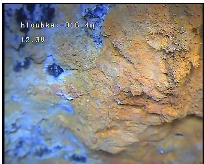
17,4 m (od O.B.) zcela uzavřená perforace minerálními nárůsty (PŘED) 17,8 m (od O.B.) otevřená perforace (PO)
