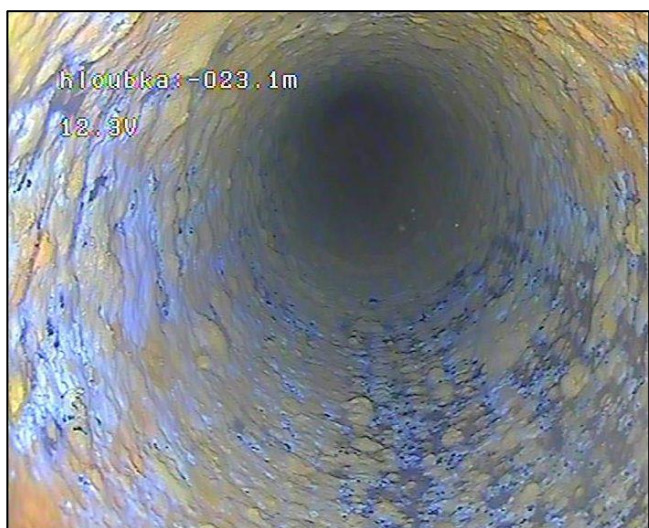
23,1 m (od O.B.) uzavřená perforace minerálními nárůsty (PŘED) 22,9 m (od O.B.) otevřená perforace (PO)
