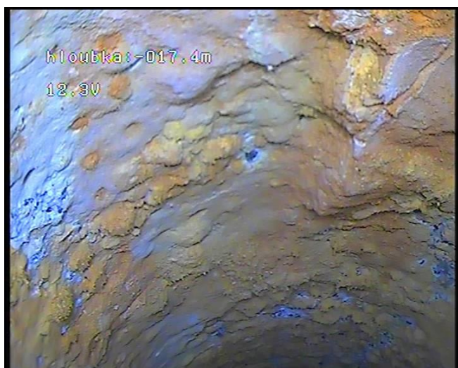
17,4 m (od O.B.) zcela uzavřená perforace minerálními nárůsty (PŘED) 17,8 m (od O.B.) otevřená perforace (PO)
