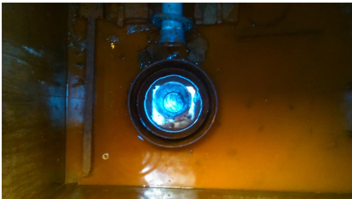
Příloha č. 2d: Vrt KV-9 – vnitřek šachtice se zhlavím vrtu
