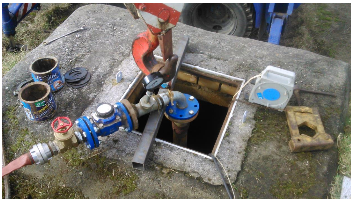
Příloha č. 2b: Vrt KV-2 - Vodoměr se škrtícím ventilem
